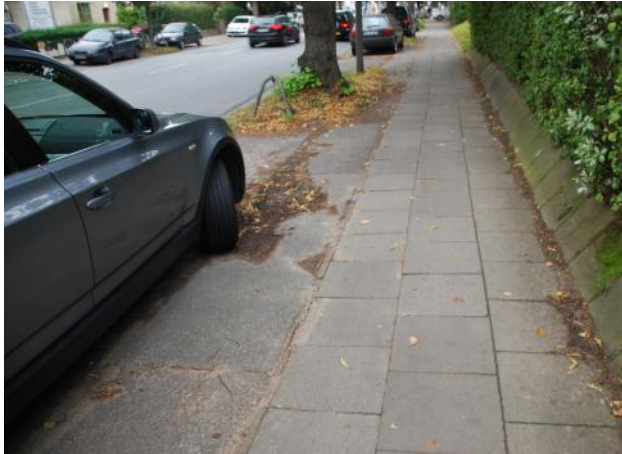
Nicht benutzbar: Radweg in der Langenhorner Chaussee.
