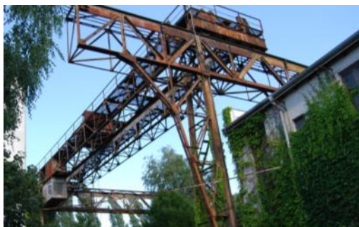
Kampnagel: Der historische Kran über dem möglichen Platz.
