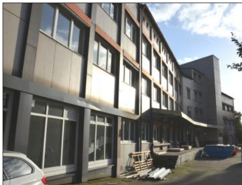
In der ehemaligen Zentrale der Firma Block an der Hufnerstraße in Barmbek werden Ende des Jahres 157 Menschen eine Zuflucht finden. Noch laufen die Bauarbeiten, um alles vorzubereiten.
