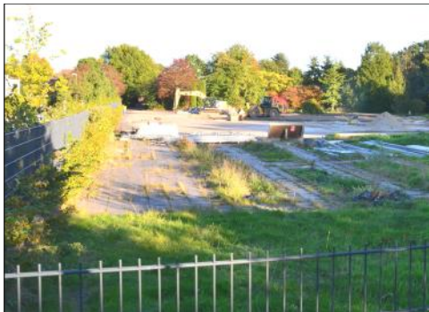
Derzeit ruhen die Arbeiten am ehemaligen Anzuchtgarten in Klein Borstel
