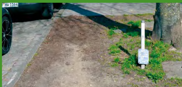
Bei der Entfernung des alten Radwegs an der Eppendorfer Landstraße wurde diese Baumscheibe vergrößert. Der Grasbewuchs markiert die alten Abmessungen der Freifläche.
