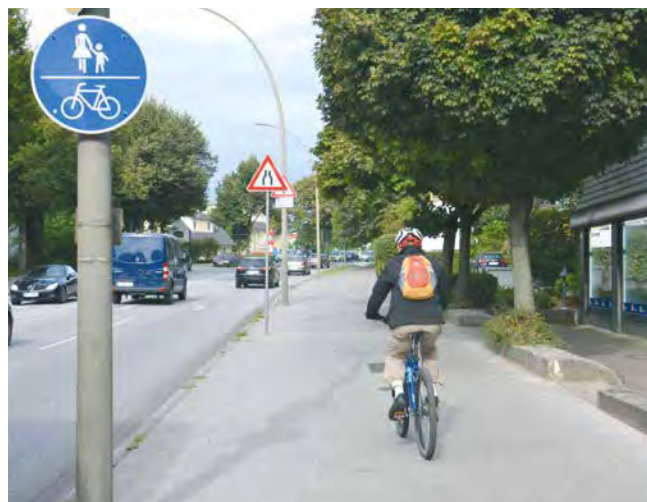
Gemeinsame Geh- und Radwege wie hier Höhe Flughafenstraße führen zu Konflikten zwischen Rad- und Fußverkehr und sollten daher vermieden werden
