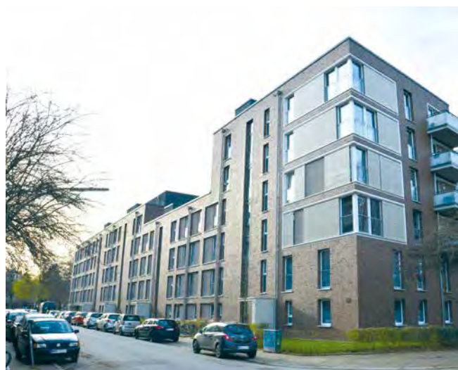
Neubau in Barmbek an der Mirowstraße
