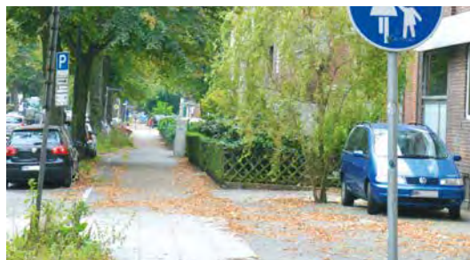
Die alten Radwege wurden genutzt, um den Gehweg zu verbreitern
