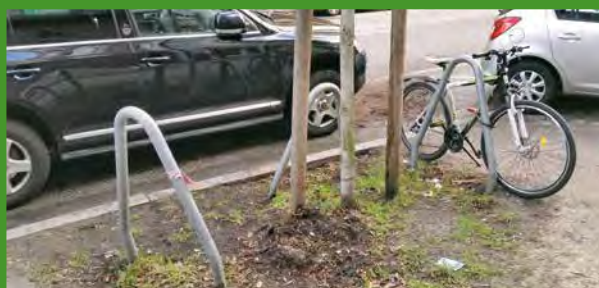
Durch drei Bügel wird dieser noch junge Baum vor Schäden durch Autos geschützt
