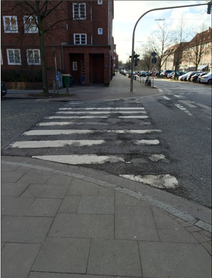
Anlage: Fotos Fußgängerüberweg
