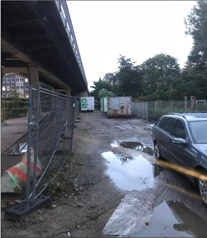
Blick auf die Trasse aus Richtung Leo-Leistikow-Allee
