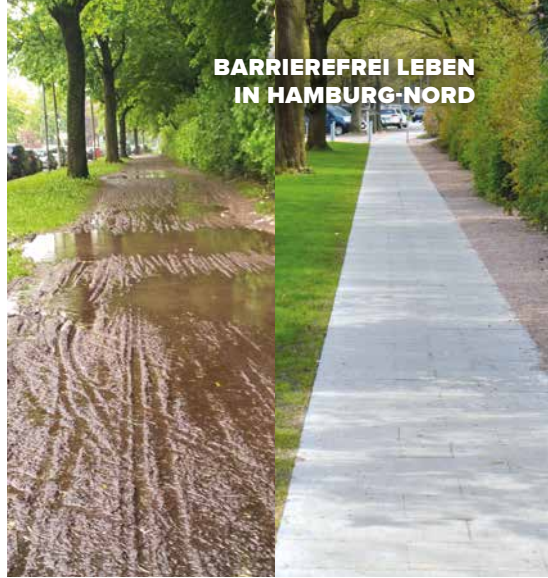
Gehweg an der Ohlsdorfer Straße vor und nach der Sanierung
